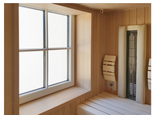
Detail: Fensterlaibung mit Hemlock-Paneelen.
