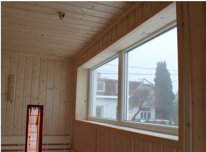
Detail: Fensterlaibung mit Fichtepaneelen („Fenster vorgezogen“).
