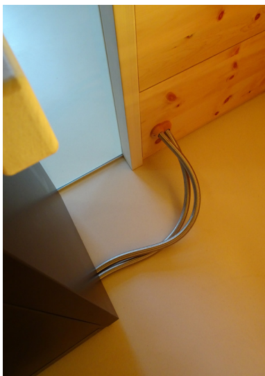
Detail: Silikonkabel, geschützt durch einen Metallschlauch (bauseits beige stellt).
