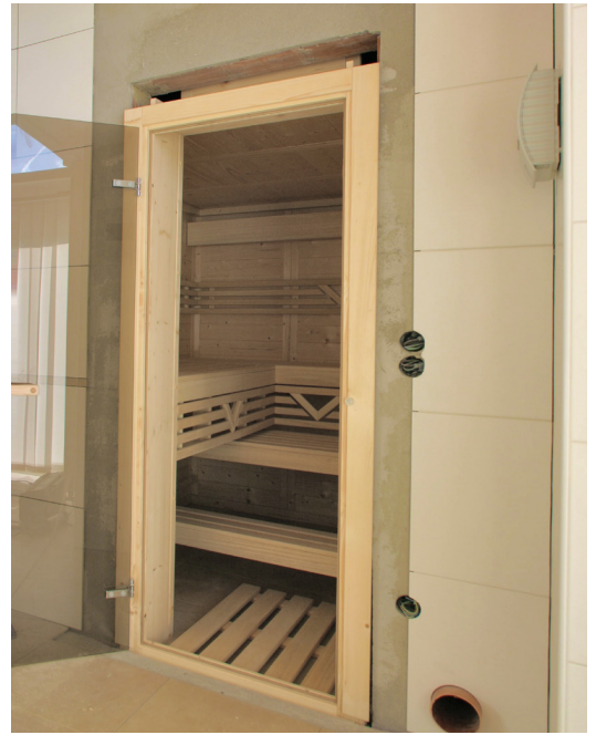
Tür vorgezogen mit Abluftkanal nach vorne
